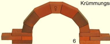
Der Korbbogen ist ein Bogen bei dem der Krümmungsradius im Bogenverlauf verändert wird.
